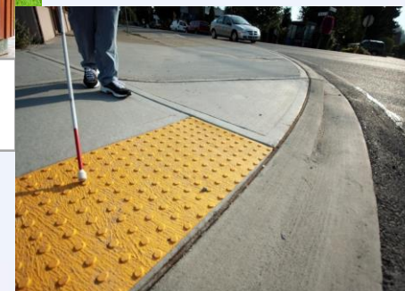
устройство тактильной плитки
