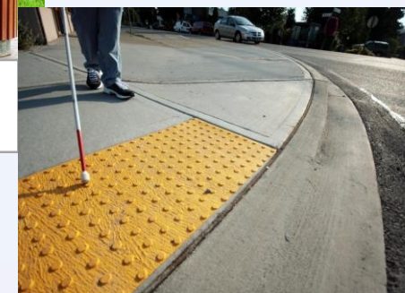
устройство тактильной плитки
